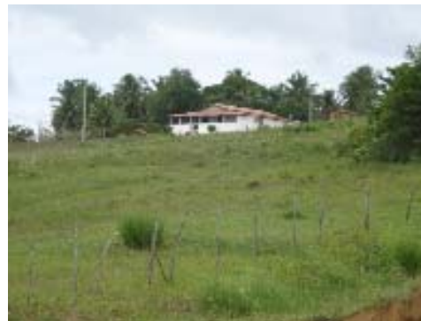
Figura 8. Casa recém construída na reserva.
