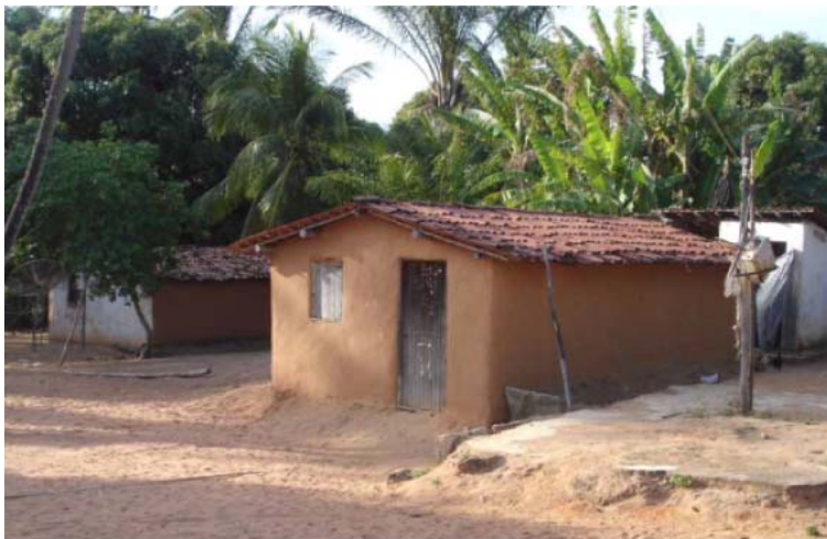
Figura 6. Aspecto geral das habitações nas diversas comunidades existentes na área. São casas de taipa, rebocadas com saibro vermelho amarelado e recobertas com telhas ou palha de coqueiro. No geral, apresentam as instalações sanitárias ao lado externo do imóvel. Fonte: Cardoso et al. (2012).
