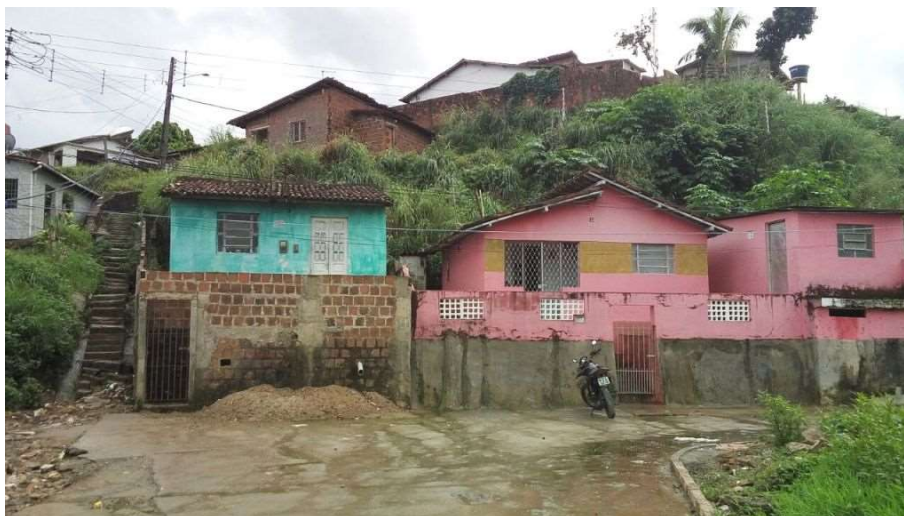
Figura 6 - base alta das casas, medida de prevenção à enchentes
