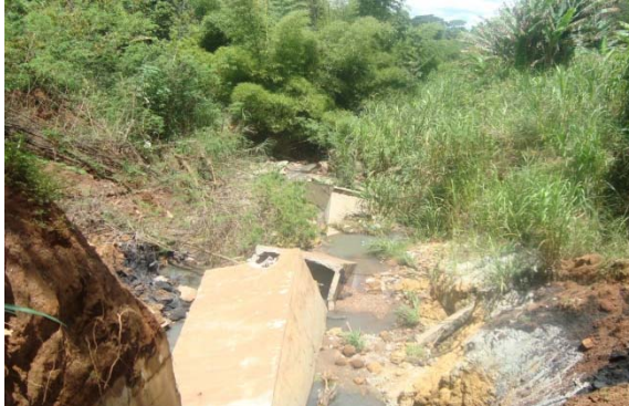
Figura 14: Degradação do fundo de vale e margens do córrego tamanduá. Fonte: http://tamanduafm.wordpress.com/2013/02/20/erosao-volta-a-engolir-parque-tamandua/
