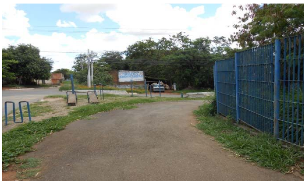
Figura 22: Entorno do parque e equipamentos de ginástica quebrados.
