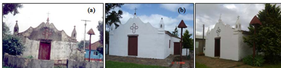
Figura 4 - Igreja Nossa Senhora dos Remédios: a) Década de 1990, b) 2006 e c) 2015.
