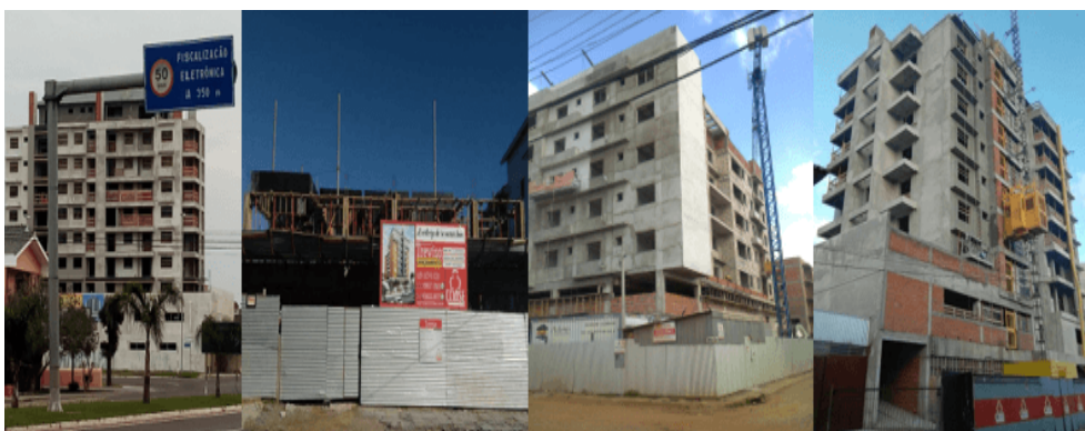
Figura 11. Edifícios em construção no bairro Camobi. Fonte: Trabalho de Campo (2017).
