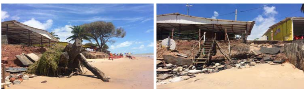
Figura 7. Praia Ponta do Seixas, litoral sul de João Pessoa PB; (PO=10) Localização: 07° 09'22" LS; 34° 47'36" LO; Indicadores de erosão, III, IV, V, VI, VII, VIII, X, XI. Destaque para a infraestrutura da orla danificada pela energia das ondas e raízes expostas. Data da foto: 09 de outubro de 2017.
