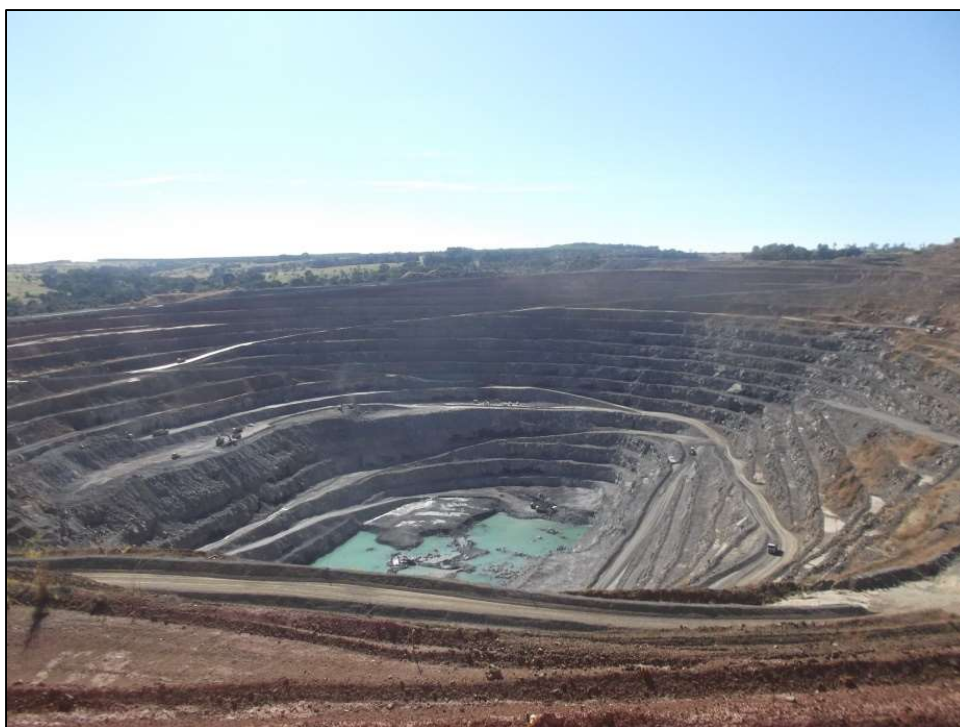
Figura 2. Vista parcial da mina Boa Vista, Catalão (GO).
