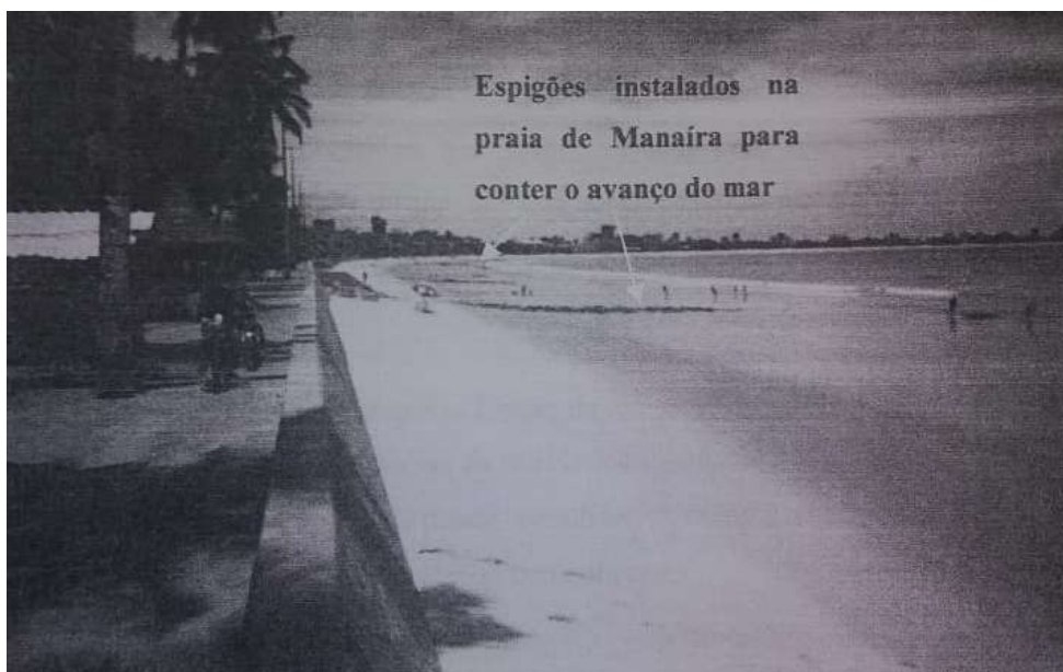
Figura 5. Resquícios de espigões construídos na praia de Manaíra.
