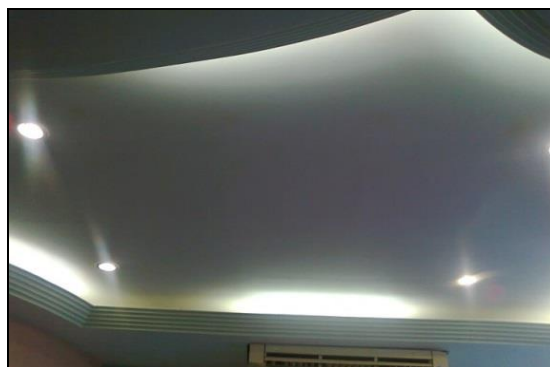
Figura 4: Utilização do branco no consultório pediátrico e obstétrico
