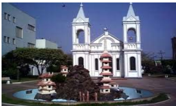
Fig. 1 – Fachada da Igreja de Santo Antônio, Três Lagoas/MS 17 .
