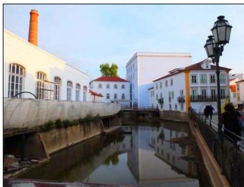
Fig. 2 – O edifício mais alto é a Moagem Austro-Húngara, no qual toda a maquinaria encontra-se repartida pelos seus diversos pisos. Foto de Helga Matos.
