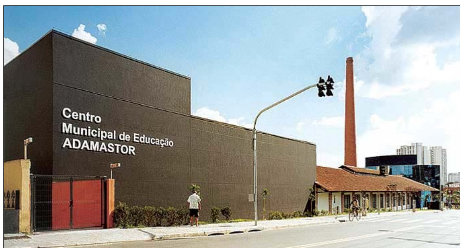
Fig. 1 – Fachada do Centro Municipal de Educação Adamastor, Guarulhos – SP.
