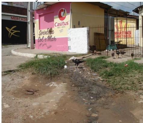
Figura 02: Esgoto a céu aberto II Fonte: Kiyotani, 2011
