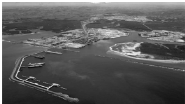
Figura 8. Vista aérea do CIPS, evidenciando porto externo e Porto Interno.
